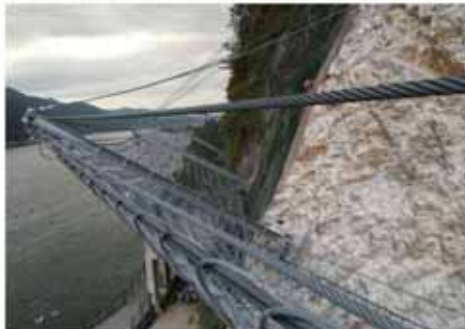
낙석발생 : 충북선 동양-삼탄간, 암괴 16톤(2.4X1.8X1.5m), 1,200kJ
